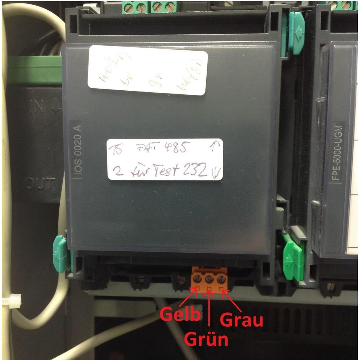
Die Schnittstelle kann zwischen FAT und Drucker umgeschaltet werden, für die Wartungsbox wird die Einstellung Drucker benötigt. !!Achtung – unüberwacht!!
